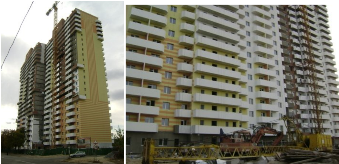
Рисунок 2. Будівельні роботи на об'єкті будівництва в м. Києві по вул. Генерала Наумова, 66 станом на листопад 2009 р.
