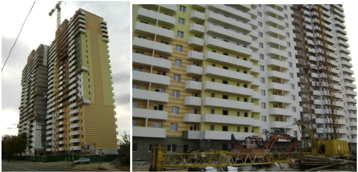
Рисунок 1. Будівельні роботи на об'єкті будівництва в м. Києві по вул. Генерала Наумова, 66 станом на 10.08.2009 р.
