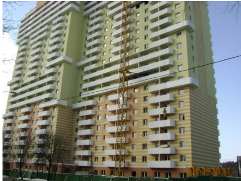
Рисунок 2. Будівельні роботи на об'єкті будівництва в м. Києві по вул. Генерала Наумова, 66 станом на березень 2010 р.
