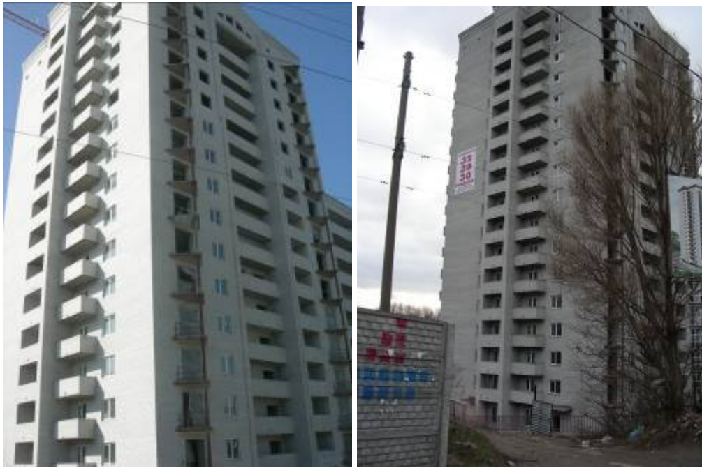
Об'єкт по вул. Тополиній, 7, м. Дніпропетровськ станом на кінець травня 2009 року та на грудень 2009 року
