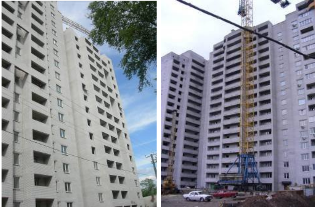
Об'єкт по вул. Дмитра Кедріна, в районі будинку №55 (III черга), м. Дніпропетровськ станом на кінець травня 2009 року та на грудень 2009 року.
