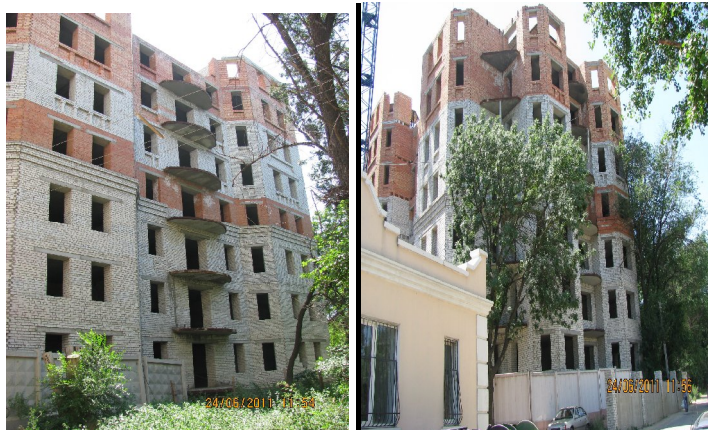
Рисунок 3. Стан будівництва по вул. Хантадзе, 7 Б у м. Іллічівську станом на червень 2011 року
