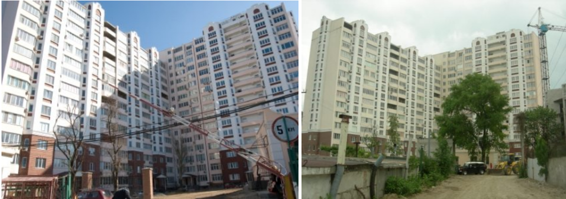
Рисунок 1. Стан будівництва по пров. Хантадзе, 4 (раніше вул. Хантадзе, 9), I та II черги у м. Іллічівську станом на березень та червень 2010 року
