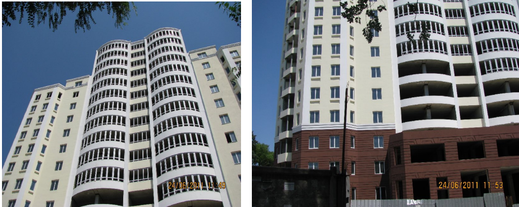
Рисунок Ошибка! Текст указанного стиля в документе отсутствует.. Стан будівництва по вул. Хантадзе, 7 А у м. Іллічівську станом на червень 2011 року
