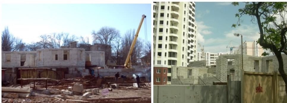
Рисунок 4. Стан будівництва по вул. Хантадзе, 7 В у м. Іллічівську станом на березень та червень 2010 року
