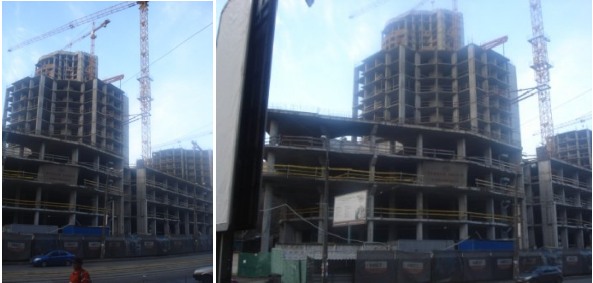
Рисунок 1. Будівельні роботи на об'єкті будівництва офісно-житлового комплексу в м. Києві на ділянці, обмеженої вулицями Глибочицькою, Студентською та Пимоненка станом на 21.11.2009 р.
