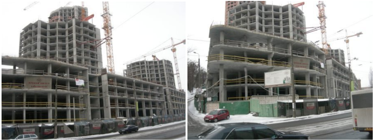
Рисунок 2. Будівельні роботи на об'єкті будівництва офісно-житлового комплексу в м. Києві на ділянці, обмеженої вулицями Глибочицькою, Студентською та Пимоненка станом на березень 2010 р.
