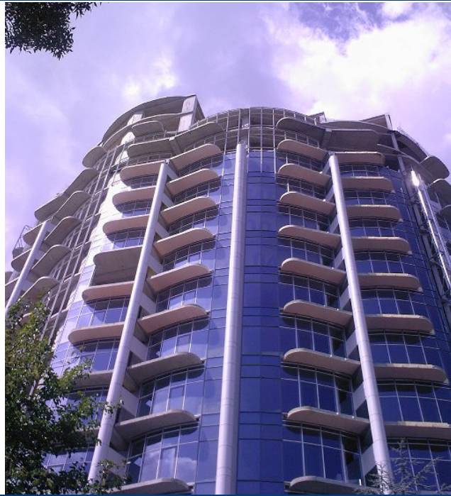
Будівництво багатоповерхового житлового будинку по вул. К. Маркса, 18а у м. Ялті станом на початок вересня 2011 року
