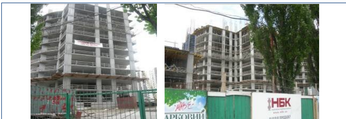
Рисунок 1.8. Будівельні роботи на секціях 1-3 житлового будинку № 26 станом на середину травня 2009 року
