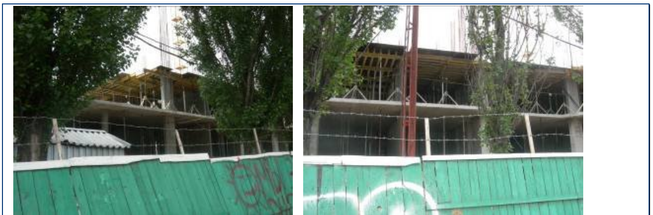
Рисунок 1.6. Будівельні роботи на секціях 1-4 житлового будинку № 28 станом на середину травня 2009 року
