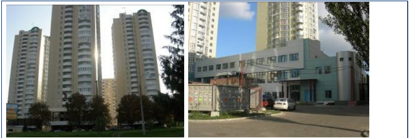
Рисунок 1.2. Житлові будинки №№ 1, 2, 3 та торговельний центр з паркінгом
