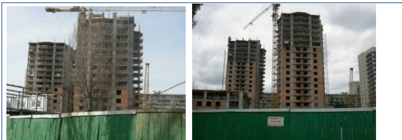
Рисунок 1.9. Будівельні роботи по житловим будинкам №№ 33 та 34 станом на початок 2008 року та станом на початок травня 2008 року
