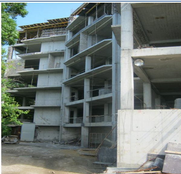
Хід будівництва рекреаційного комплексу по вул. Луговського в смт. Сімеїз станом на кінець червня 2011 року
