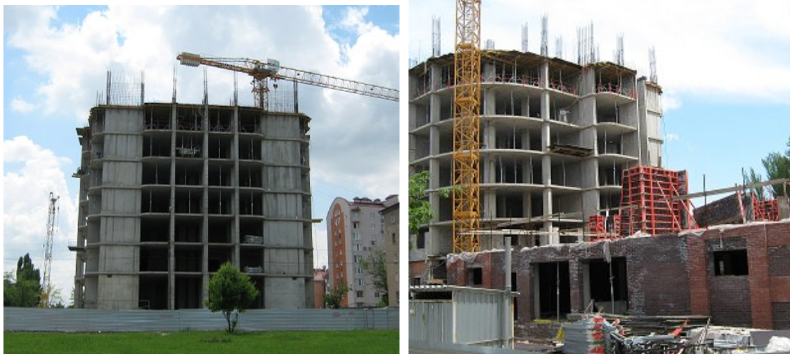
Хід будівництва житлового будинку на розі бульвару Шкільного та проспекту Миру в м. Донецьку станом на 29.05.2009 р.
