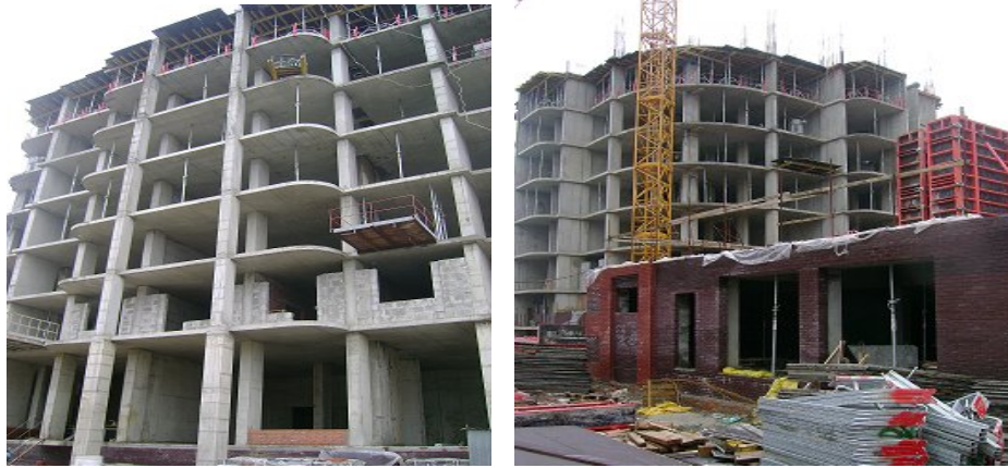
Хід будівництва житлового будинку на розі бульвару Шкільного та проспекту Миру в м. Донецьку станом на 25.03.2009 р.
