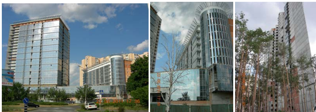
Будівельні роботи на об'єкті «Артеміда» за адресою м. Київ, перехрестя Дарницького бульвару та вул. Генерала Жмаченка станом на червень 2011 р.
