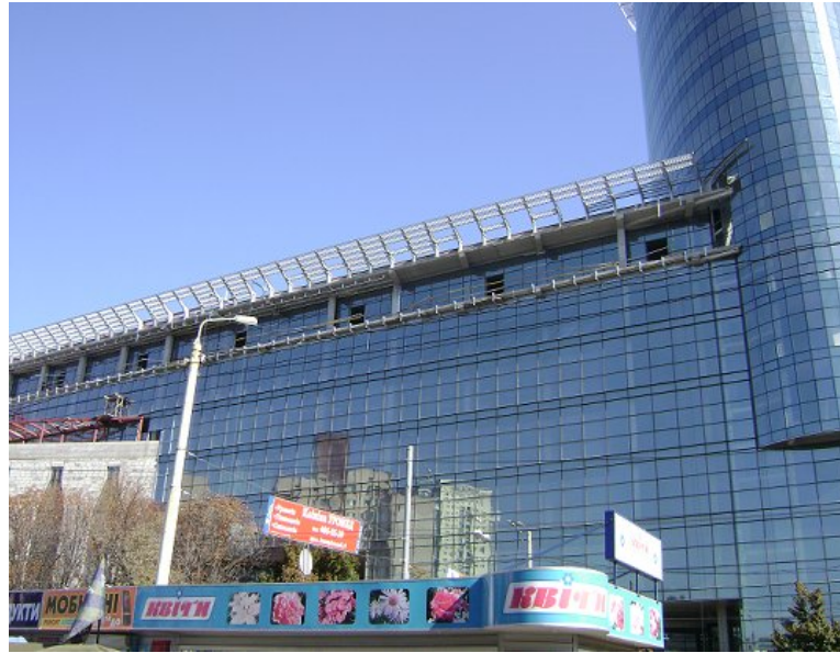
Хід робіт на об'єкті будівництва по вул. Мельникова, 2/10, станом на 01.12.2009 р.
