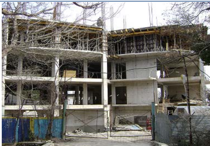
Хід будівництва рекреаційного комплексу по вул. Луговського в смт. Сімеїз станом на 09.03.2011 р.
