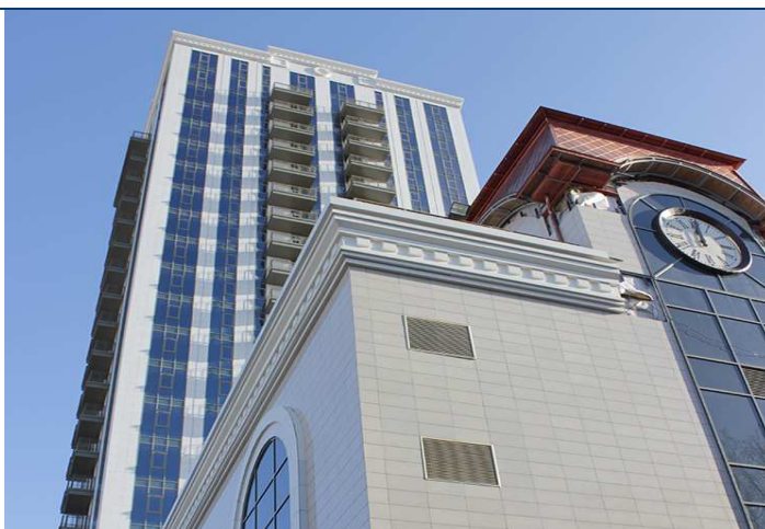
Хід будівництва житлово-офісного комплексу по вул. Воровського, 21 у м. Києві станом на кінець березня 2016 року
