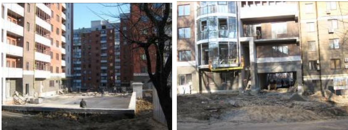
Хід робіт на об'єкті будівництва по вул. Херсонській (будинок та паркінг), у районі буд. № 9 А, станом на кінець лютого 2009 року
