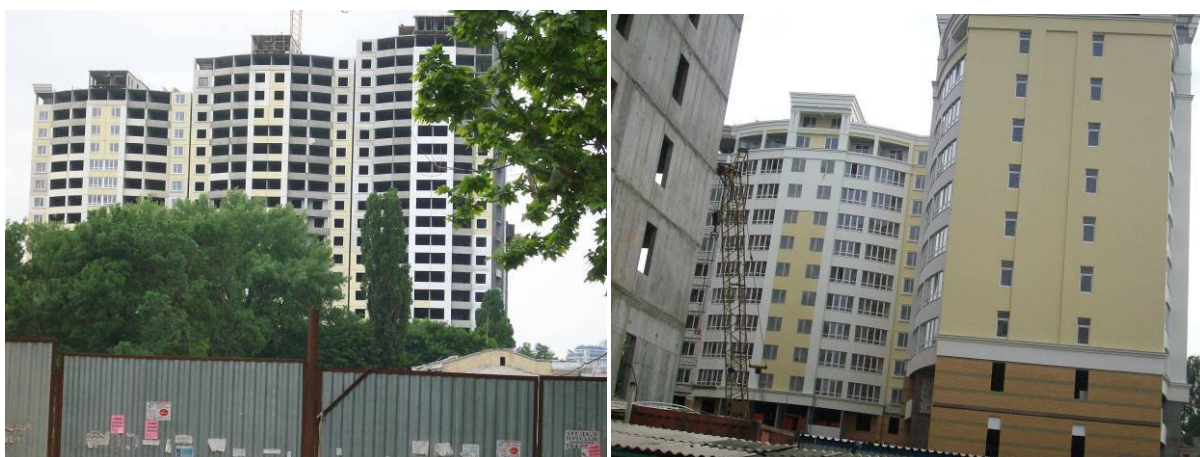
Рисунок 1.1. Будівництво житлового комплексу вул. Армієвської, 11 станом на 29.05.2009 р.
