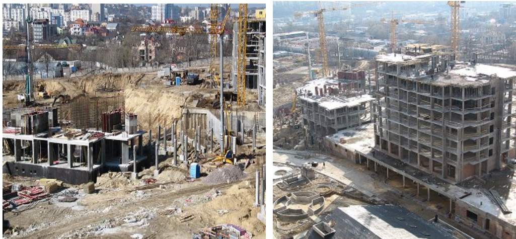
Хід будівництва II черги житлового кварталу з об'єктами соціально-громадського призначення по вул. Професора Підвисоцького у Печерському районі м. Києва станом на початок квітня 2012 року
