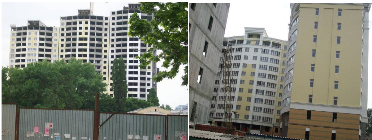
Будівництво житлового комплексу вул. Армійській, 11 станом на 29.05.2009 р.
