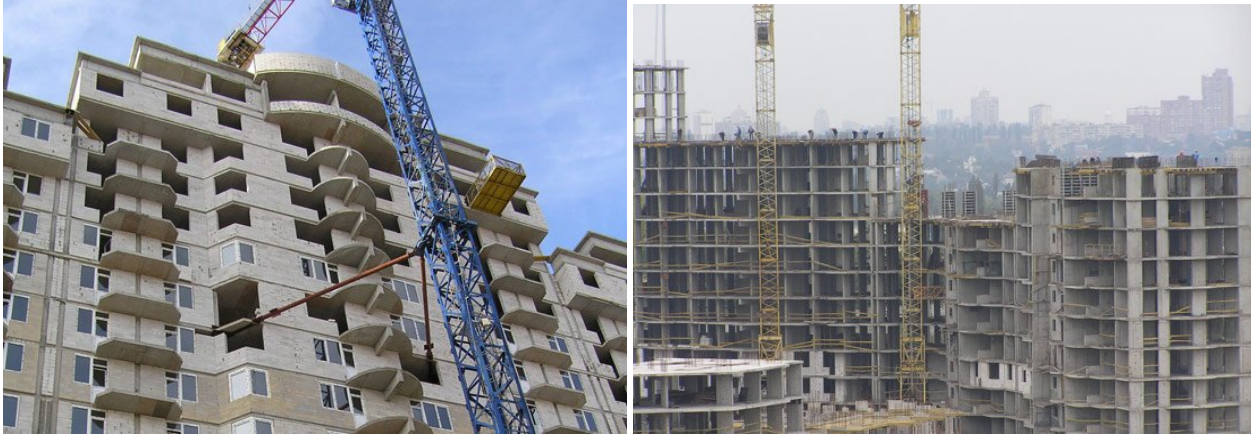
Рисунок 1. Стан будівництва житлових будинків з підземними паркінгами та закладів з обслуговування населення по вул. Вільямса,7 та вул. Ломоносова, 42-50 (III мікрорайон) у м. Києві станом на жовтень 2009 р.
