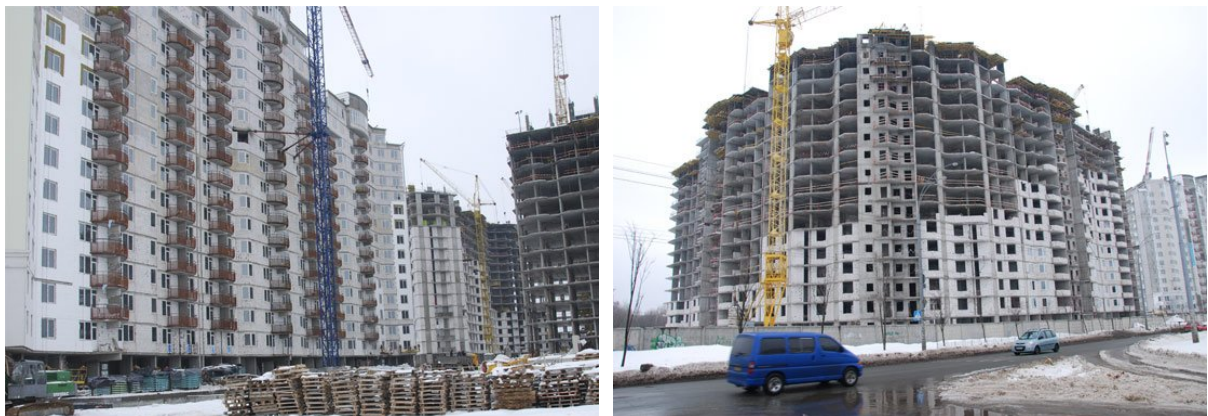
Рисунок 2. Стан будівництва житлових будинків з підземними паркінгами та закладів з обслуговування населення по вул. Вільямса,7 та вул. Ломоносова, 42-50 (III мікрорайон) у м. Києві на березень 2010 р.
