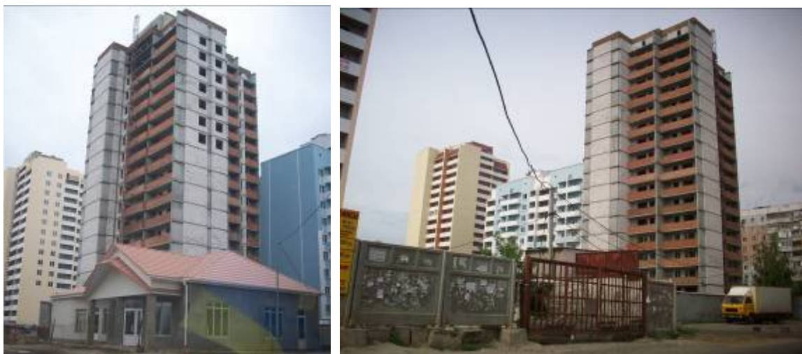
Об'єкт будівництва - житловий будинок № 27 у мікрорайоні III-4-2 Котовського у м. Одесі станом на 20.02.2009 р. та станом на 29.05.2009 р.
