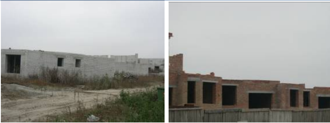
Об'єкт незавершеного будівництва - житловий комплекс з об'єктами соціально-побутової інфраструктури по вул. Леніна, 119 у с. Петропавлівська Борщагівка Києво-Святошинського району Київської області станом на листопад 2009 року
