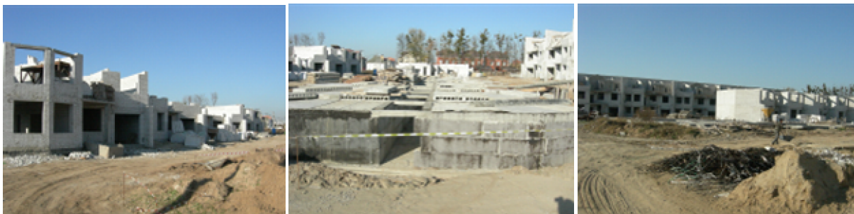
Хід будівництва житлового комплексу з об'єктами соціально-побутової інфраструктури по вул. Леніна, 119 у с. Петропавлівська Борщагівка Києво-Святошинського району Київської області станом середину листопада 2008 року та на середину лютого 2009 року
