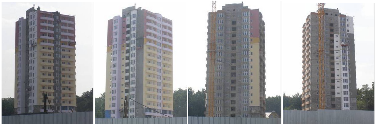
Стан будівництва житлового комплексу Grand Life в м. Ірпені Київської області станом на 28.08.2009 р.
