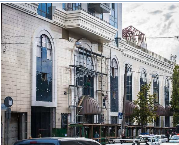
Хід будівництва житлово-офісного комплексу по вул. Воровського, 21 у м. Києві станом на середину вересня 2015 року
