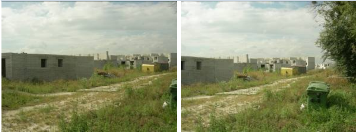
Об'єкт незавершеного будівництва - житловий комплекс з об'єктами соціально-побутової інфраструктури по вул. Леніна, 119 у с. Петропавлівська Борщагівка Києво-Святошинського району Київської області станом на вересень 2010 року
