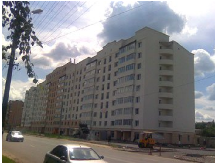
Житловий будинок по вул. Білогорській, 17-21 у м. Боярці
