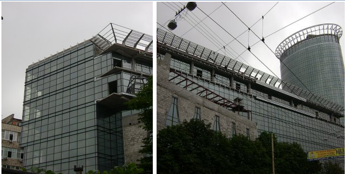
Хід робіт на об'єкті будівництва по вул. Мельникова, 2/10, станом на 24.06.2010 р.
