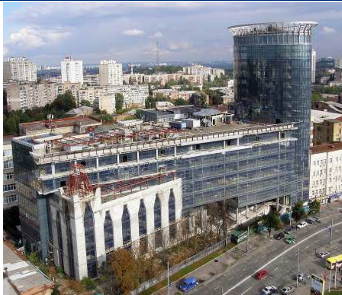
Об'єкт незавершеного будівництва по вул. Мельникова, 2/10, станом на початок вересня 2013 року
