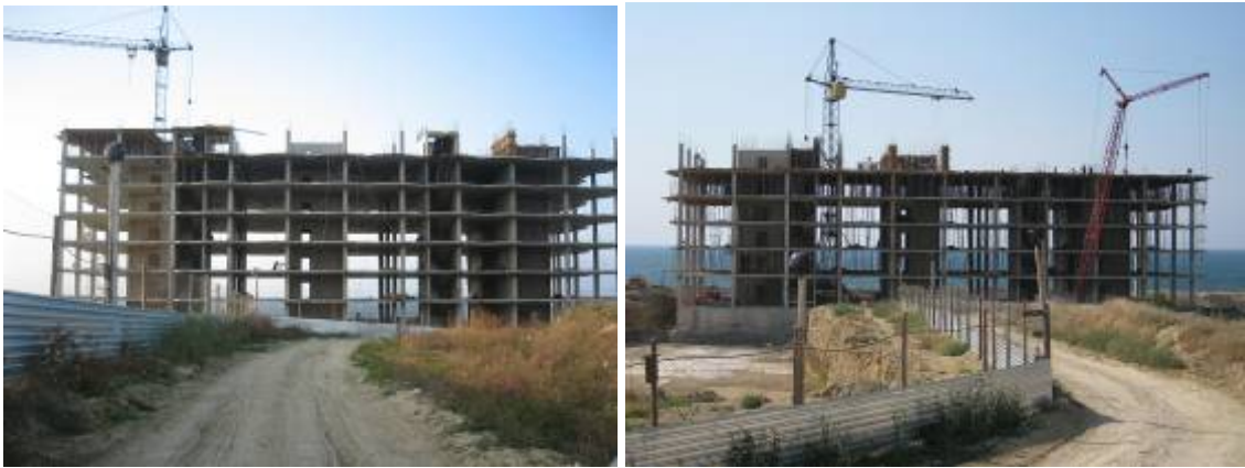
Хід робіт на об'єкті будівництва в районі парку Перемоги в м. Севастополі
