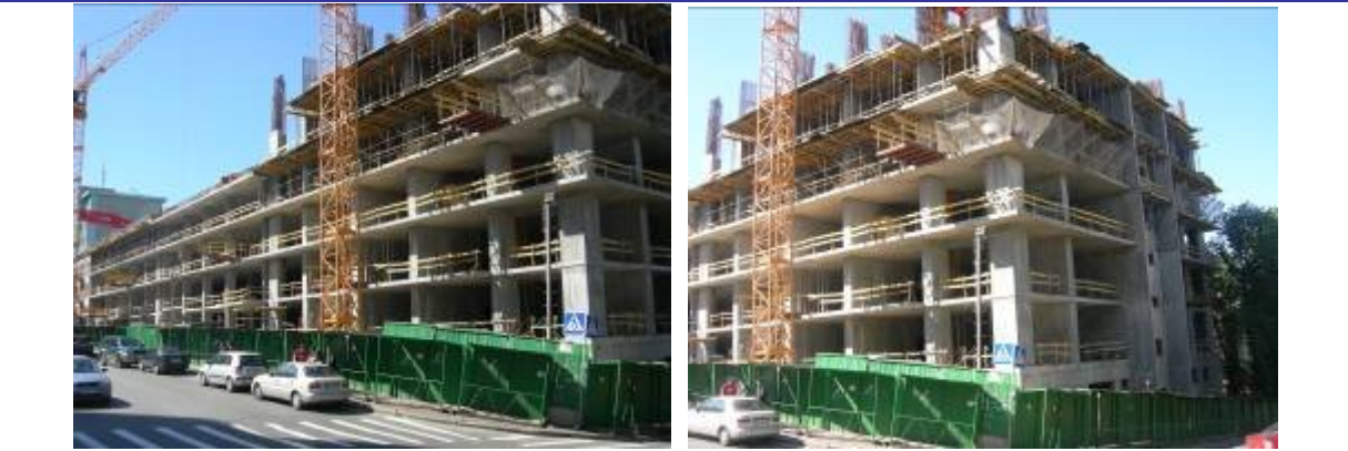
Рисунок 1.2. Будівельні роботи на об'єкті будівництва, обмеженого вулицями Предславинською, Ульянович та Червоноармійською станом на 04.06.2009 р.
