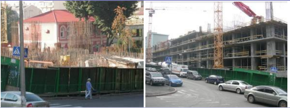
Рисунок 1.1. Будівельні роботи на об'єкті будівництва, обмеженого вулицями Предславинською, Ульянович та Червоноармійською станом на 21.08.2008 р. та 31.03.2009 р
