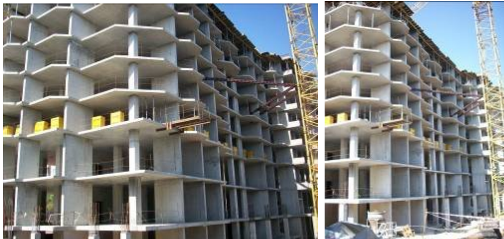
Хід робіт на об'єкті будівництва по вул. Малиновського (на розі вул. Заводської та пров. Союзного) в м. Одесі станом на початок вересня 2009 р.
