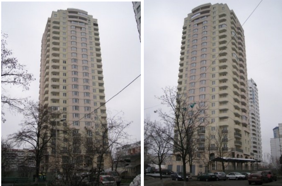
Рисунок 4. Житловий будинок у м. Києві на розі вулиці Героїв Дніпра та проспекту Героїв Сталінграду
