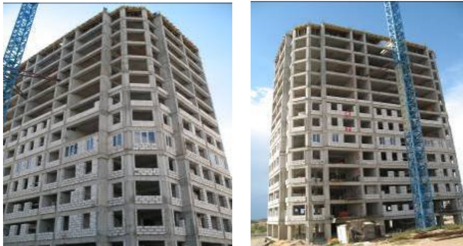
Стан виконання будівельних робіт по корпусу 6 в мікрорайоні «Омега-2а» у м. Севастополі станом на травень 2009 року
