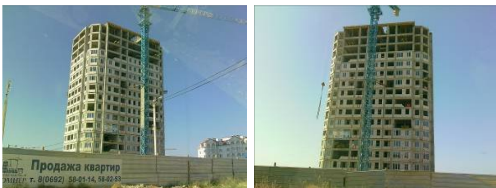
Стан виконання будівельних робіт по корпусу 6 в мікрорайоні «Омега-2а» у м. Севастополі станом на кінець серпня 2009 року
