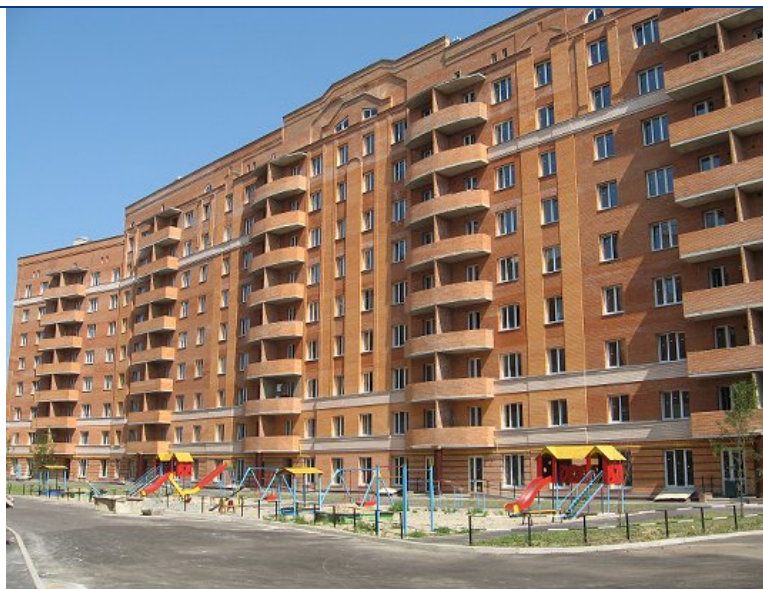
Житловий будинок по вул. Жовтневій, 40-Д у м. Полтаві, станом на 19.07.2010 р.
