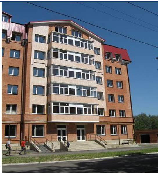
Житловий будинок по вул. Паризької комуни, 20 у м. Полтаві, станом на 21.07.2010 р.
