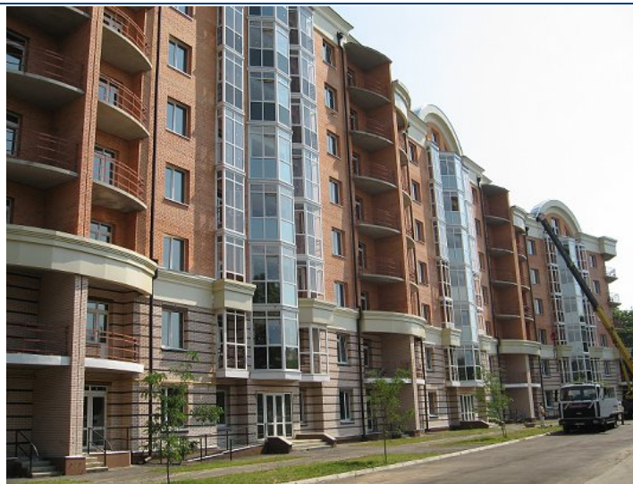
Житловий будинок по вул. Жовтневій, 40-В у м. Полтаві, станом на 19.07.2010 р.
