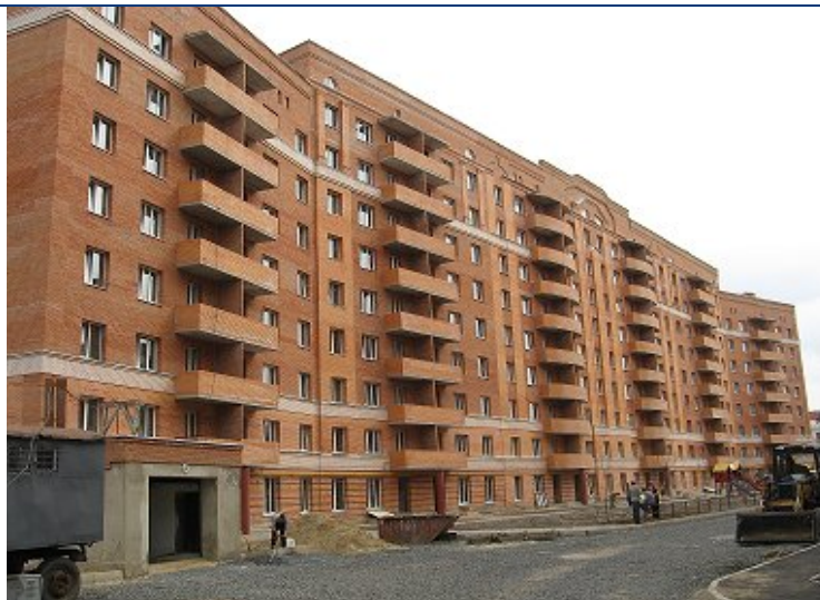
Житловий будинок по вул. Жовтневій, 40-Д у м. Полтаві, станом на 20.04.2010 р.
