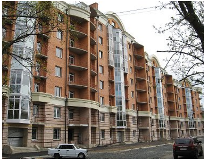
Житловий будинок по вул. Жовтневій, 40-В у м. Полтаві, станом на 20.04.2010 р.
