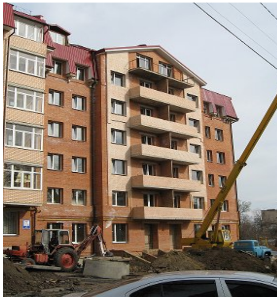
Житловий будинок по вул. Паризької комуни, 20 у м. Полтаві, станом на 20.04.2010 р.
