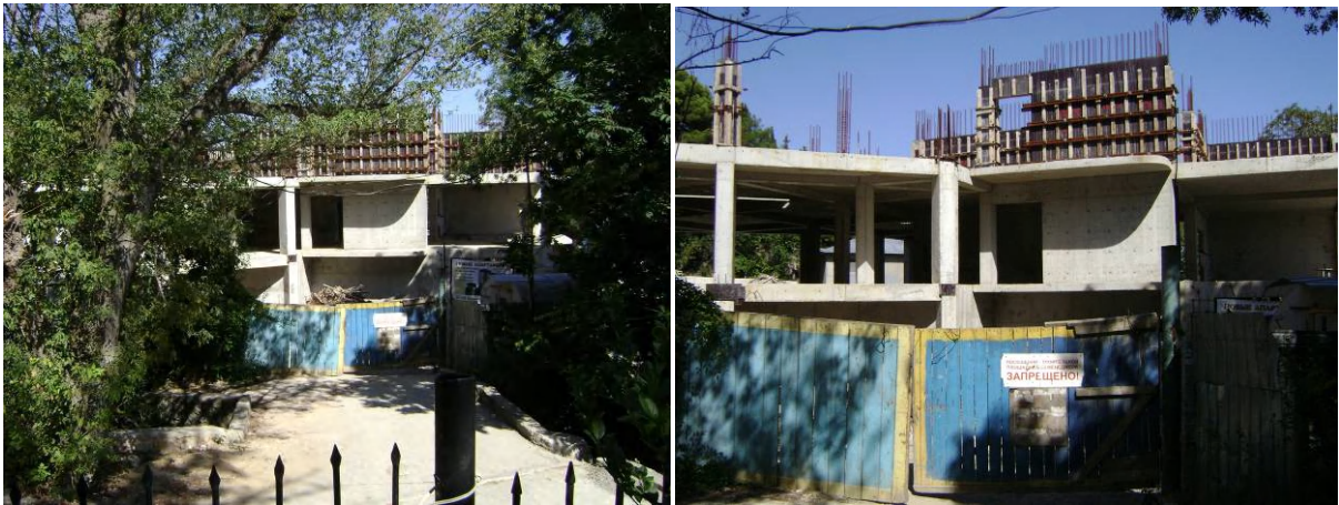
Хід будівництва рекреаційного комплексу по вул. Лугоського в смт. Сімеїз станом на 21.08.2009 р.
