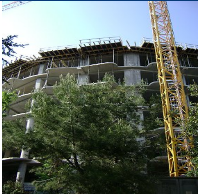
Будівництво багатопверхового житлового будинку по вул. К. Маркса, 18а у м. Ялті станом на 21.08.2009 р
