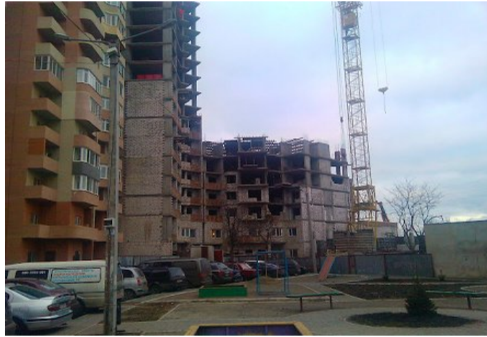
Стан будівництва громадсько-житлового комплексу у мікрорайоні ім. Таїрова на розі вул. 25-ї Чапаївської дивізії та просп. Маршала Жукова у м. Одесі станом на початок 2012 року
