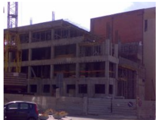
Будівництво багатофункціонального комплексу по вул. Шевченка, 53, станом на початок червня 2008 року
