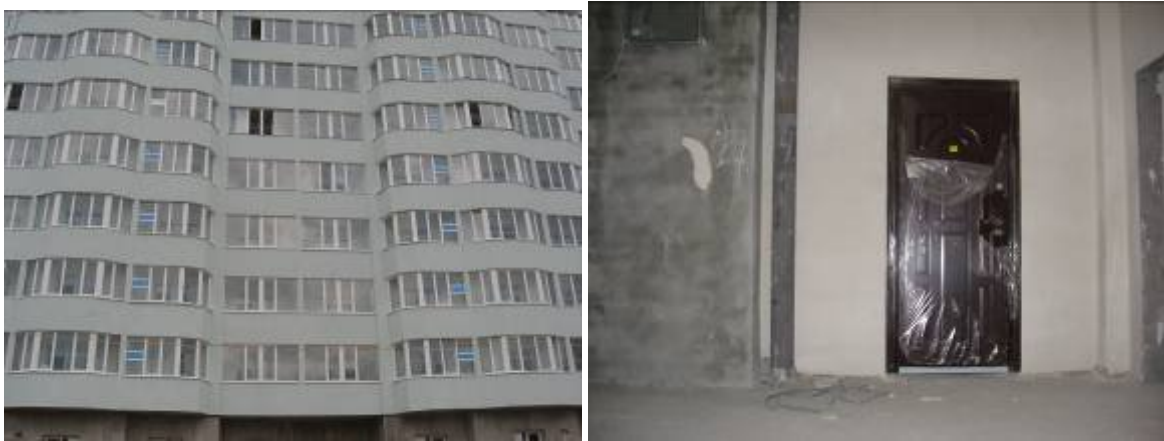
Рисунок 1.2. Стан будівництва 2-х житлових будинків по вул. Рєпіна, 19 у м. Севастополі станом на березень 2009 р.
