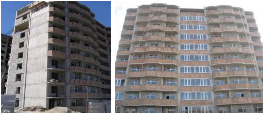
Рисунок 1.1. Стан будівництва 2-х житлових будинків по вул. Рєпіна, 19 у м. Севастополі станом на 05.09.2008 р. та станом на 25.10.2008 р.
