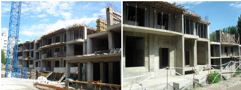
Будівельні роботи по вул. Грязнова станом на середину травня 2009 року
