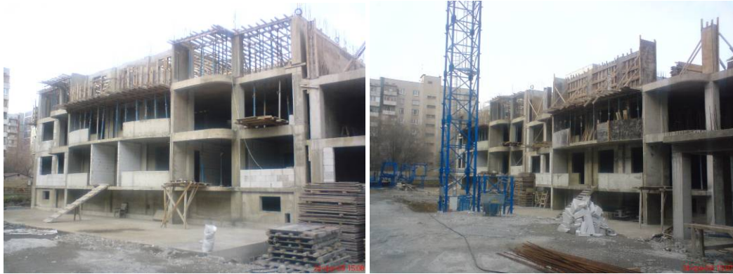
Будівельні роботи по вул. Грязнова станом на середину лютого 2009 року
