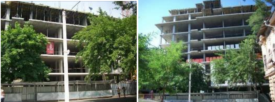
Будівництво житлового будинку по вул. Відрадній, 13 станом на кінець травня 2009 року та на початок вересня 2009 року
