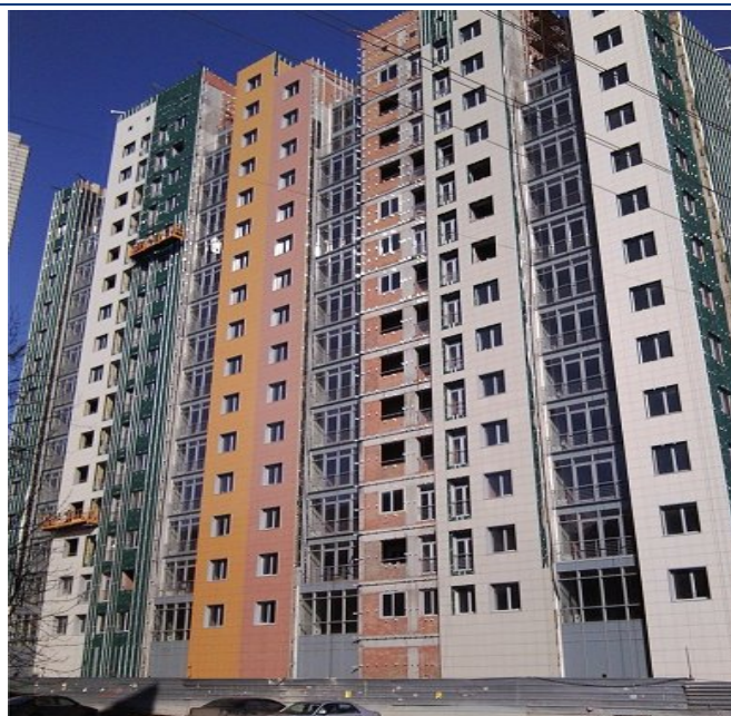
Хід робіт на об'єкті будівництва по пров. Ламаному в м. Дніпропетровську станом на початок березня 2012 року
