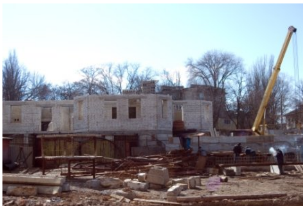
Рисунок 3. Стан будівництва по вул. Хантадзе, 7 В у м. Іллічівську станом на березень 2010 року
