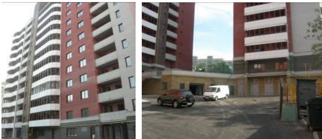
Об'єкт будівництва по вул. Херсонській (будинок та паркінг), у районі буд. № 9 А
