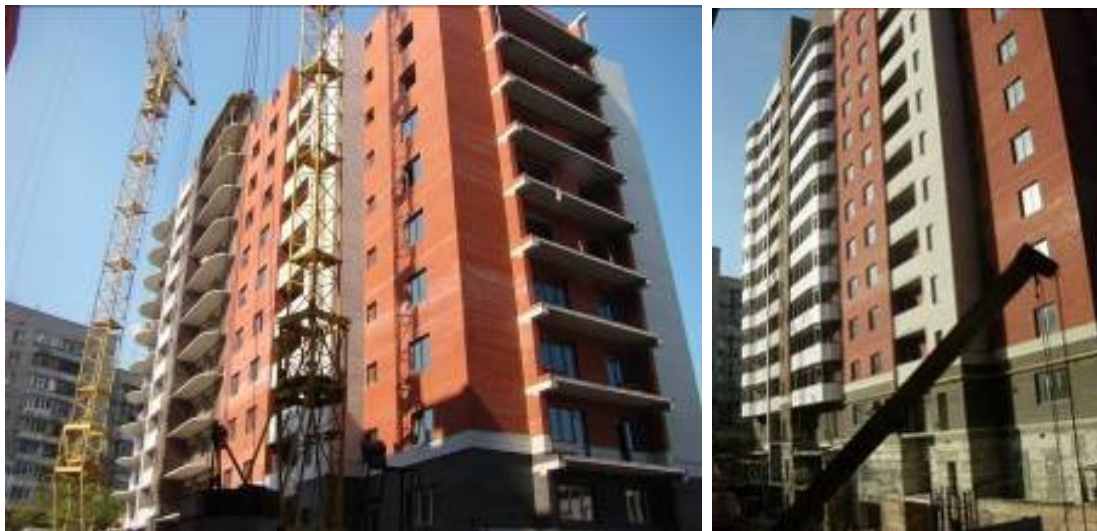
Хід робіт на об'єкті будівництва по вул. Херсонській, у районі буд. № 9 А, станом на травень 2008 року та на кінець листопада 2008 року
