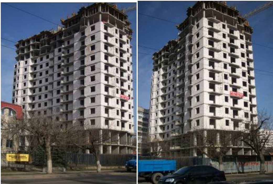
Хід робіт на об'єкті будівництва по вул. Малиновського (на розі вул. Заводської та пров. Союзного) в м. Одесі станом на початок березня 2010 р.
