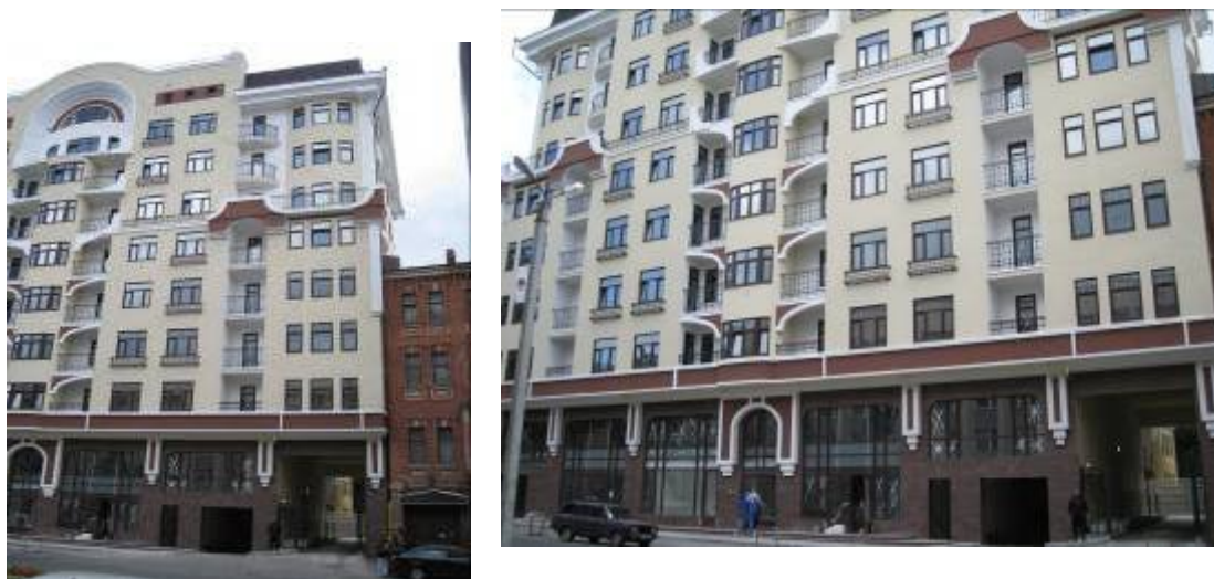
Стан будівництва житлового будинку по вул. Чернишевського, 50-52 у м Харкові на 21.08.2009 р.
