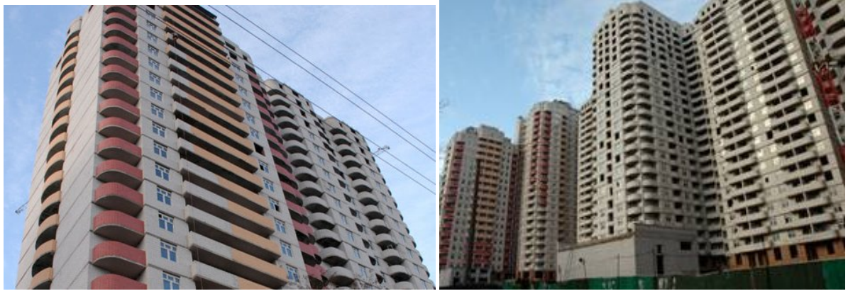
Рисунок 1. Будівельні роботи по вул. Майорова, 5А
