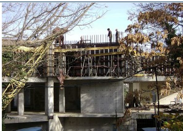
Хід будівництва рекреаційного комплексу по вул. Луговського в смт. Сімеїз станом на 12.11.2010 р.
