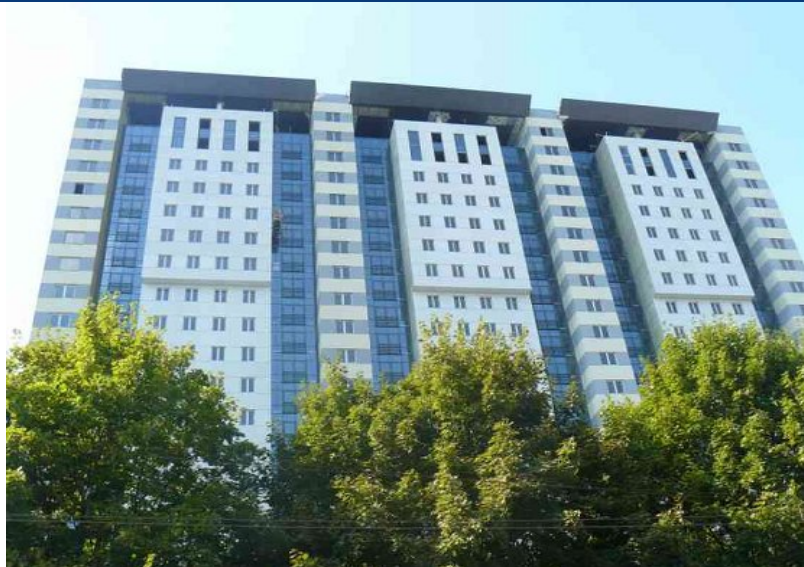
Хід робіт на об'єкті будівництва по вул. Ульянова, в районі буд. 17 А у м. Дніпропетровську станом на кінець вересня 2009 р.
