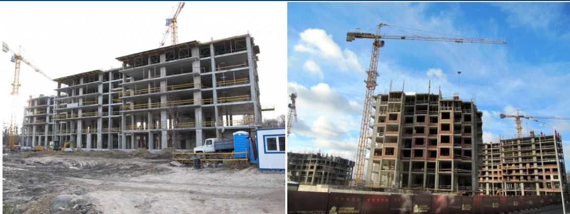
Рисунок Ошибка! Текст указанного стиля в документе отсутствует..1. Хід будівництва другої черги житлового кварталу з об'єктами соціально-громадського призначення по вул. Професора Підвисоцького у Печерському районі м. Києва на лютий 2011 року та травень 2011 року (зліва направо)
