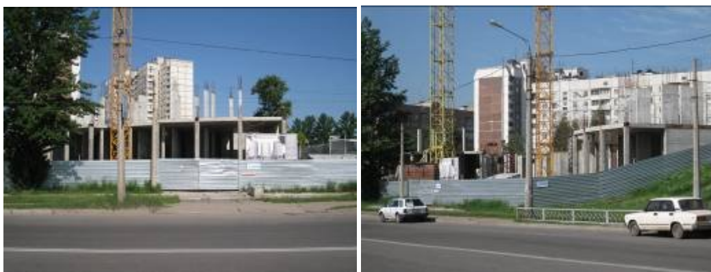
Рисунок 1.1. Будівництво ж/б з вбудовано-прибудованими приміщеннями культурно-побутового, адміністративного призначення та торговельного центру, з підземним паркінгом та гостьовою автостоянкою по вул. Шевченка (район вул. Саперної) у м. Харкові
