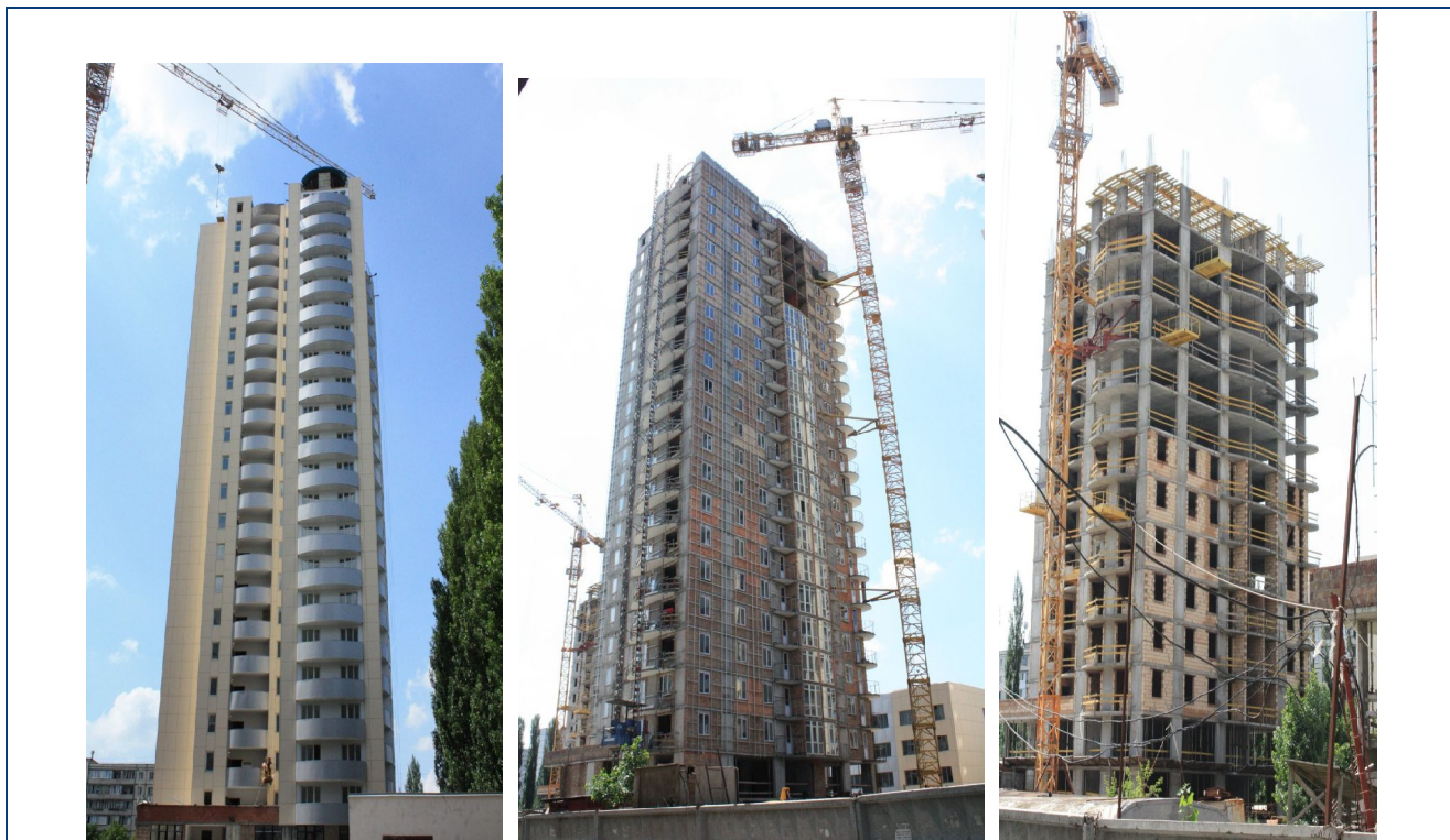
Рисунок 6. Будівельні роботи по житловим будинкам №№ 33 та 34 та № 35 станом на липень 2011 року
