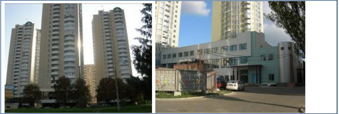
Рисунок 1. Житлові будинки №№ 1, 2, 3 та торговельний центр з паркінгом
